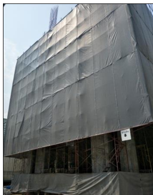
รูปที่ 4.1.4-1 ตัวอย่างผ้าใบ (Mesh Sheet) ตลอดแนวด้านข้างอาคารห้องชุดขณะก่อสร้าง
